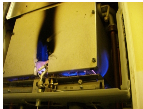
Verschmutzte Therme Abgase können nicht abziehen
